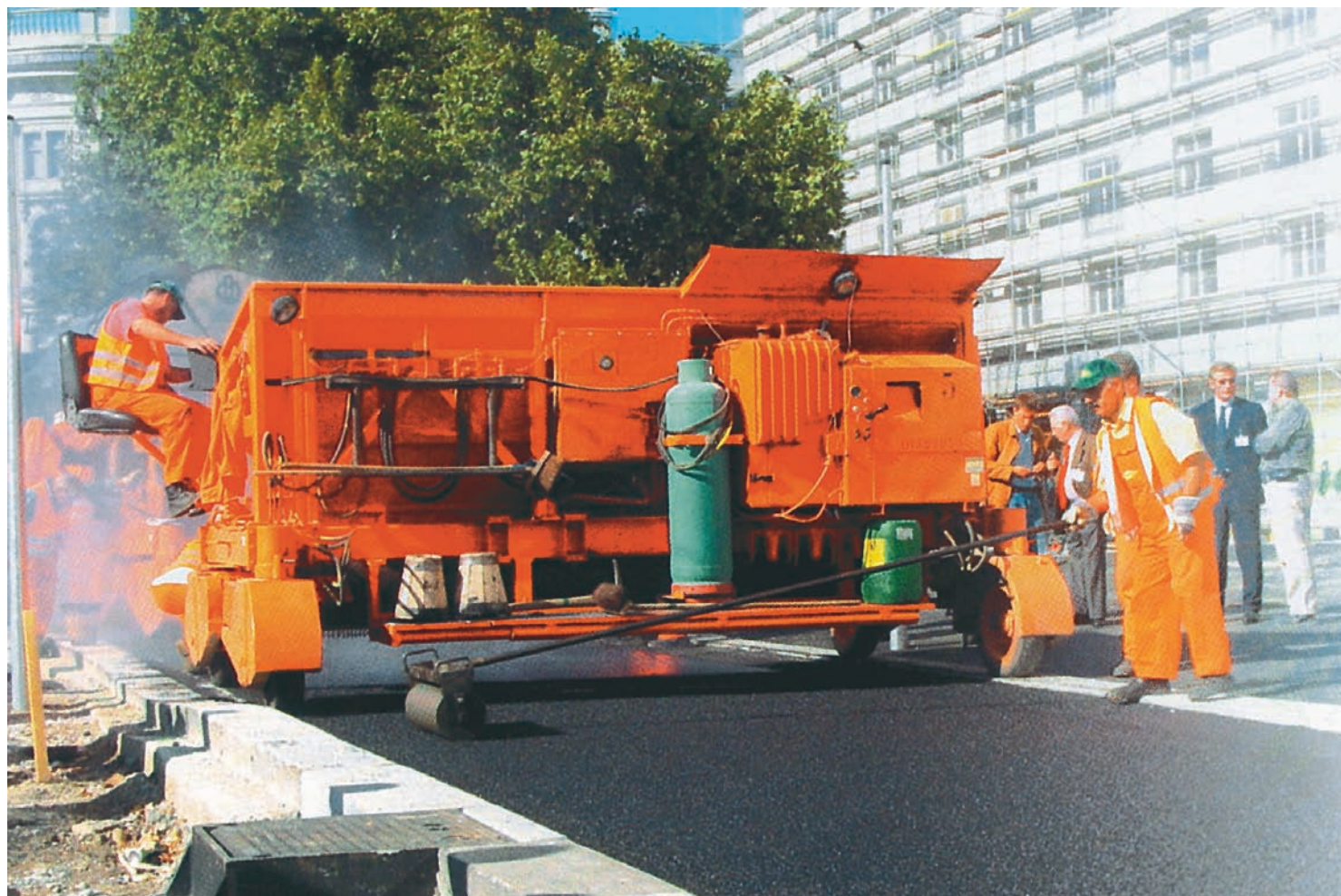
Fig. 9 Pavimentatrice per la stesa dell'asfalto colato
