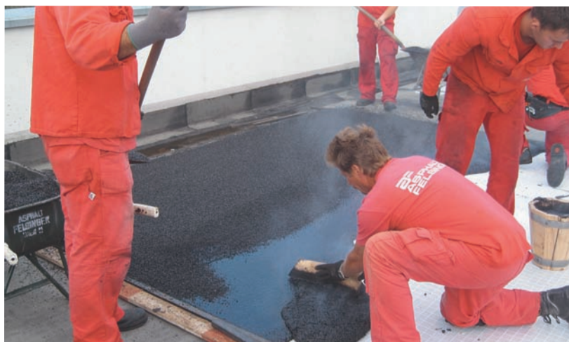
Fig. 8 Operazioni di posa in opera su settori rettangolari discontinui
