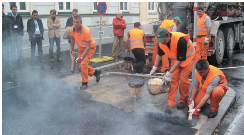
Fig. 4 Operazioni di stesa del colato a Vienna (Seestadt Aspern)
