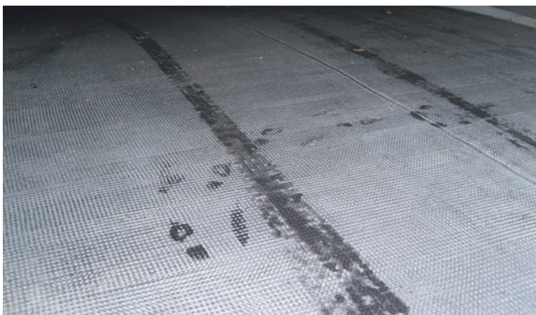
Fig. 3 Particolare di un trattamento di irruvidimento
