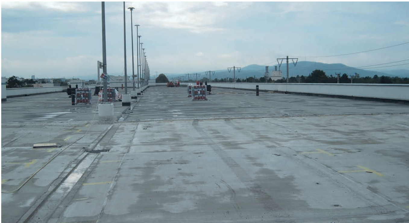
Fig. 6 Asfalto colato per l'impermeabilizzazione di una terrazza-parcheggio
