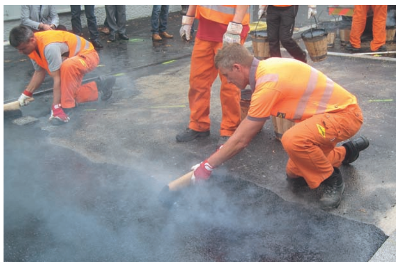
Fig. 1 Asfalto colato steso a mano
