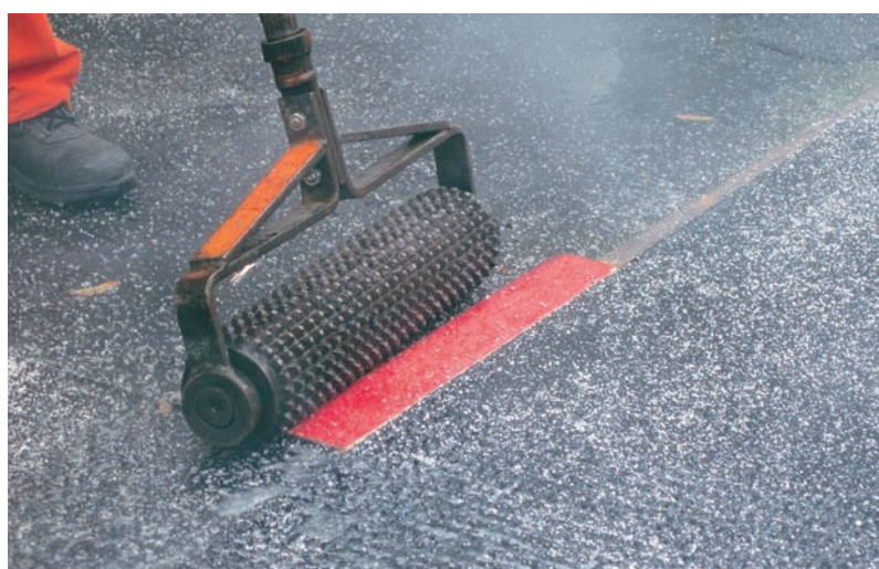
Fig. 5 Il rullo per l'irruvidimento dell'asfalto colato appena steso
