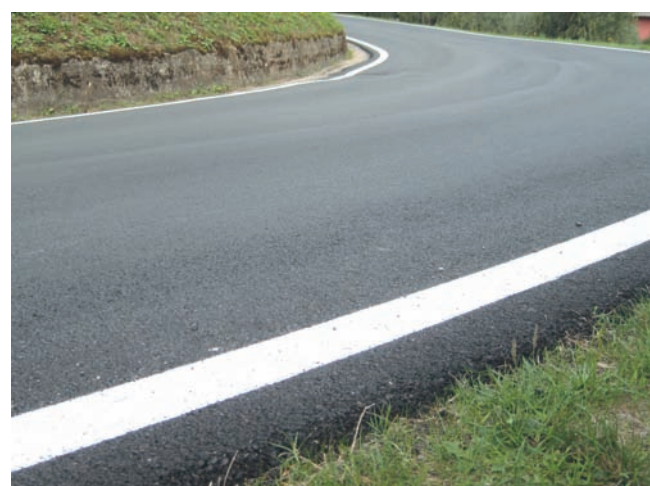
Fig. 6 Un particolare del manto stradale rifatto
