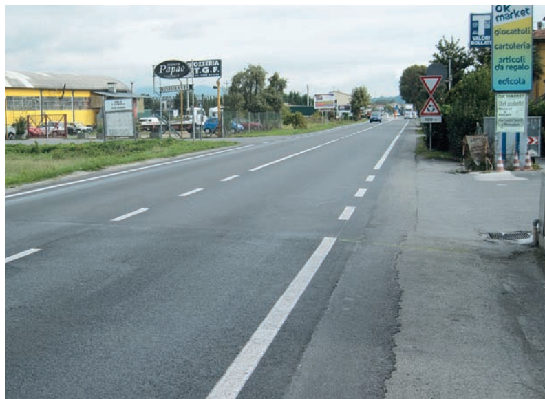
Fig. 4 L'asfaltatura del tratto iniziale della Pesciantina: si nota lo stacco tra un tratto sperimentale fatto con asfalto speciale (in basso) e l'asfalto convenzionale
