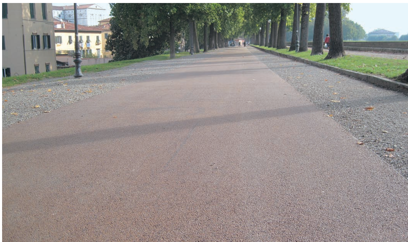
Fig. 2 La pavimentazione in asfalto chiaro realizzata sui bastioni delle mura
