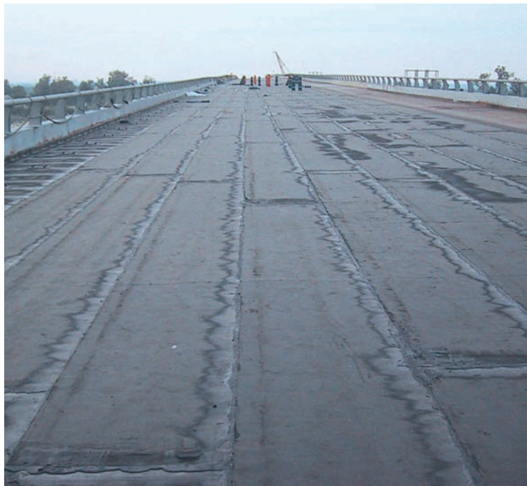
Fig. 2 La fase di impermeabilizzazione di un viadotto con membrane bitume-polimero
