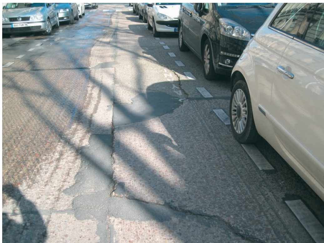
Fig. 2 Una corsia di sosta in conglomerato cementizio
