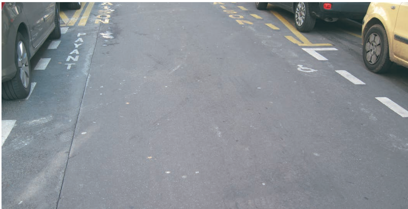
Fig. 5 Il manto asfaltico di Rue de Courty, rifatto nel 2004
