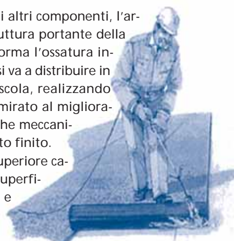
Fig. 2 Posa a caldo delle membrane con cannello
