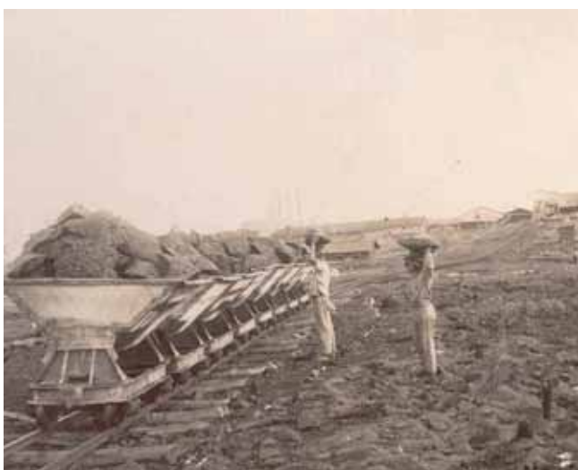
Pitch Lake anni '20. Fasi di estrazione dell'asfalto naturale
