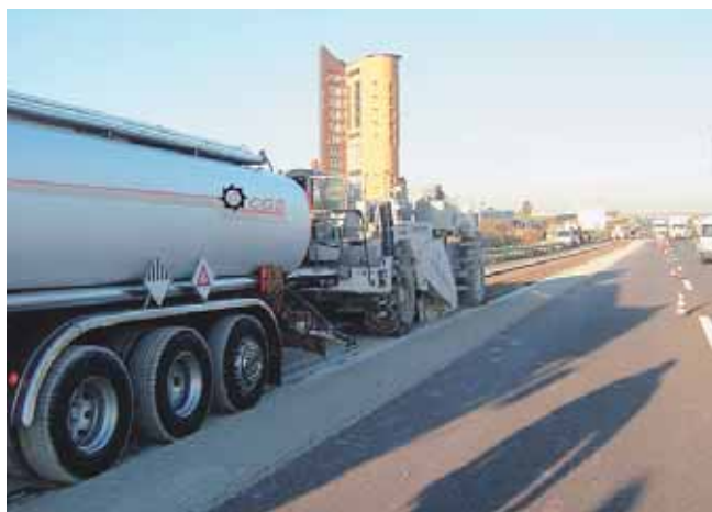
Fase di riciclaggio a freddo in situ
