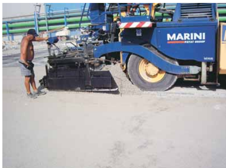
Fig. 27 Stesa del misto cementato
