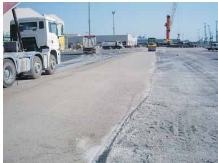
Fig. 28 Compattazione di una strisciata di misto cementato
