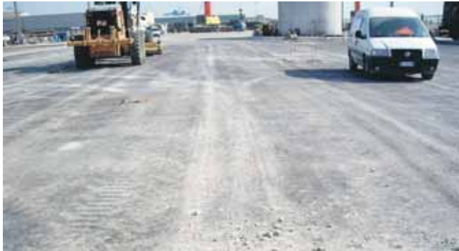
Fig. 29 Pavimentazione in conglomerato bituminoso alto modulo
