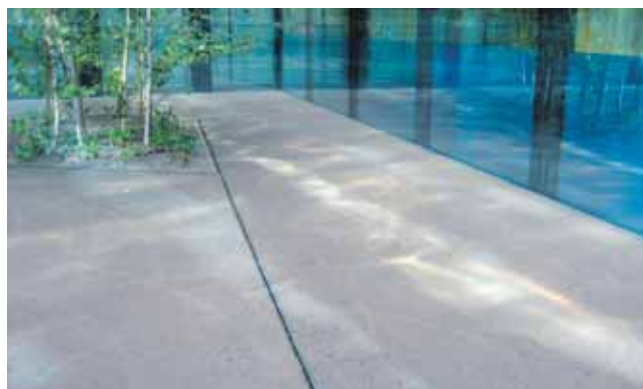
Fig. 6 Zona esterna alla stazione
