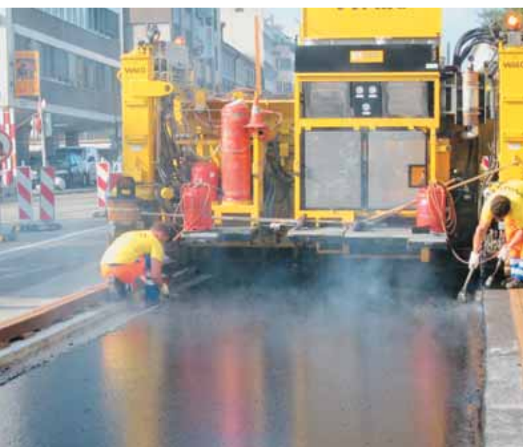
Fig. 7 Stesa del colato in una via di Basilea
