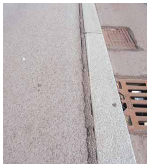
Fig. 11 Particolare di un giunto longitudinale >>
