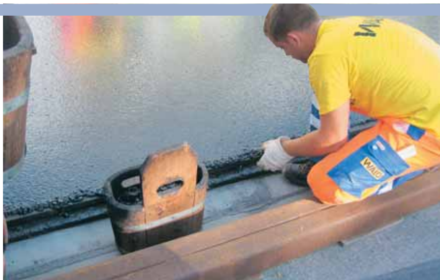
Fig. 9 Posa del doppio strato con controllo della rifinitura
