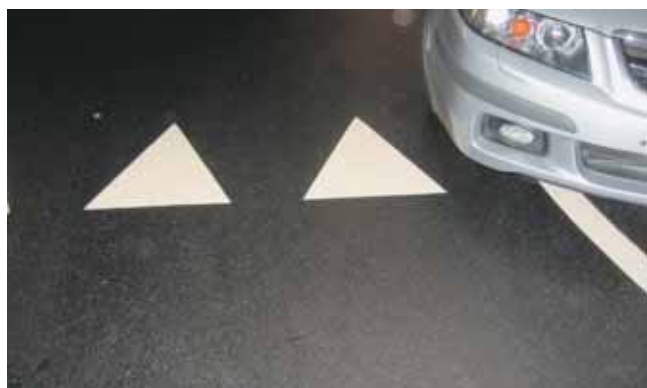
Fig. 5 Particolare della pavimentazione del parcheggio sotterraneo
