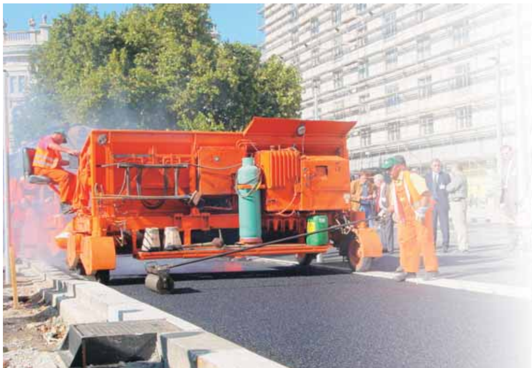
Fig. 2 Macchina per applicazione stradale del colato, Vienna 2003
