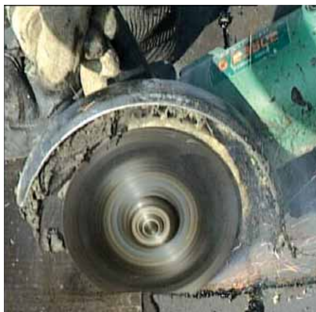
Fig. 6 Fasi di taglio della membrana da una terrazza
