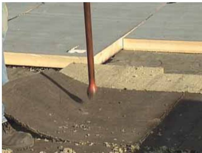
Fig. 7 Distacco della membrana da una terrazza
