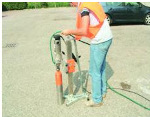
Fig. 6 Prelievo di campioni mediante carotaggio meccanico
