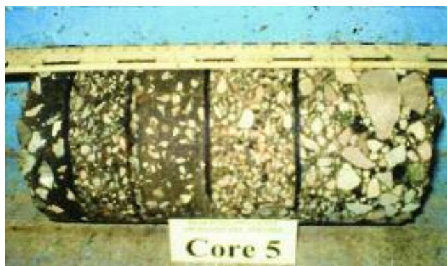
Fig. 3 Carota prelevata in fase di studio preliminare
