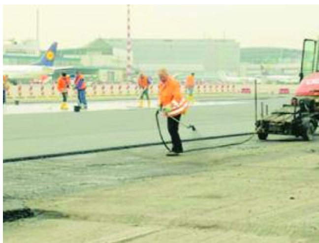
Fig. 2 Stesa della mano di attacco
