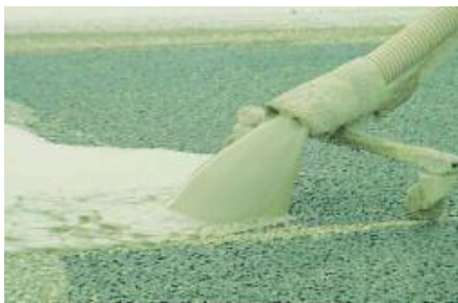
Fig. 3 Intasamento del conglomerato con malta cementizia
