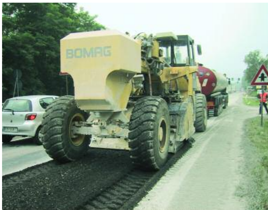
Fig. 1 Riciclaggio a freddo in situ su tratte stradali di ANAS
