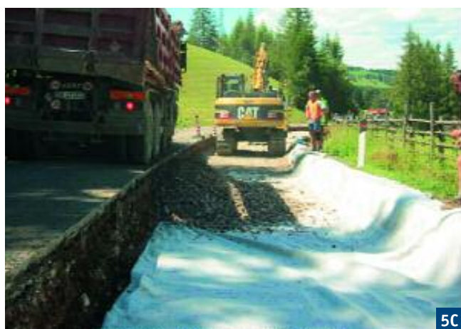
Fig. 5 Correzione granulometrica sulla SP14 di Aldino
