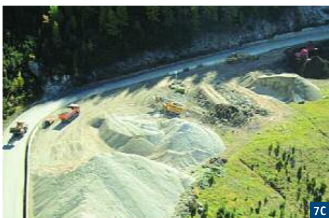
Fig. 7 Risanamento profondo antigelo a Passo Sella
