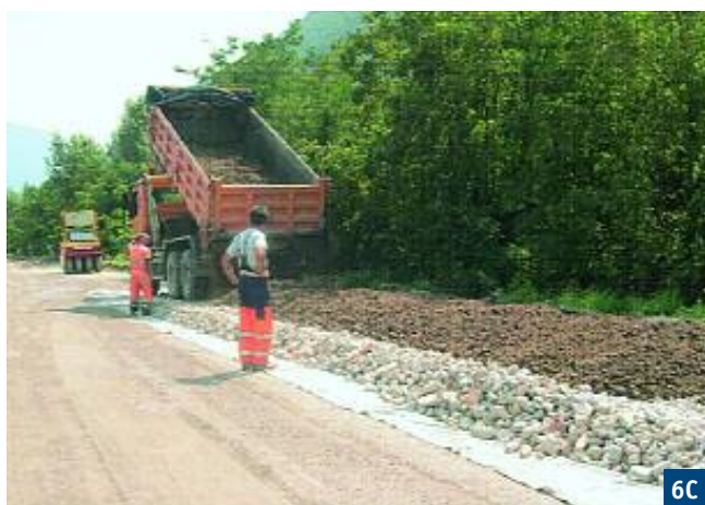
Fig. 6 Correzione granulometrica sulla SP 172 di Ischia Frizzi
