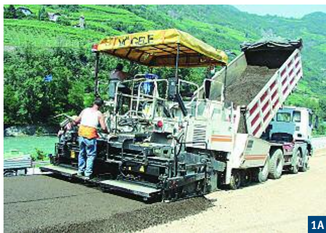
Fig. 1 Stesa di misto cementato confezionato con inerti di riciclo
