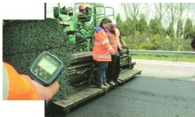
Fig. 1 Stesa del conglomerato semicaliente e controllo della temperatura
