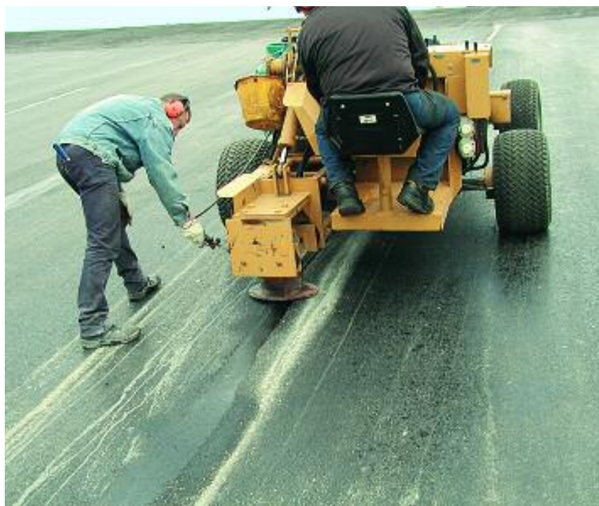
Fig. 12 Riscaldamento e ribattitura dei giunti
