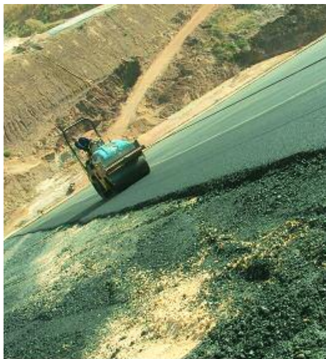
Fig. 11 Prima compattazione con rullo vibrante da 2,5 t
