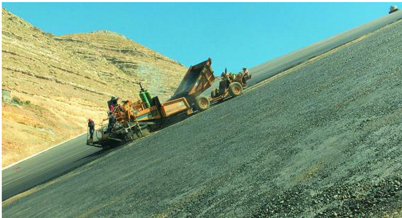
Fig. 9 Il dumper alimenta la finitrice
