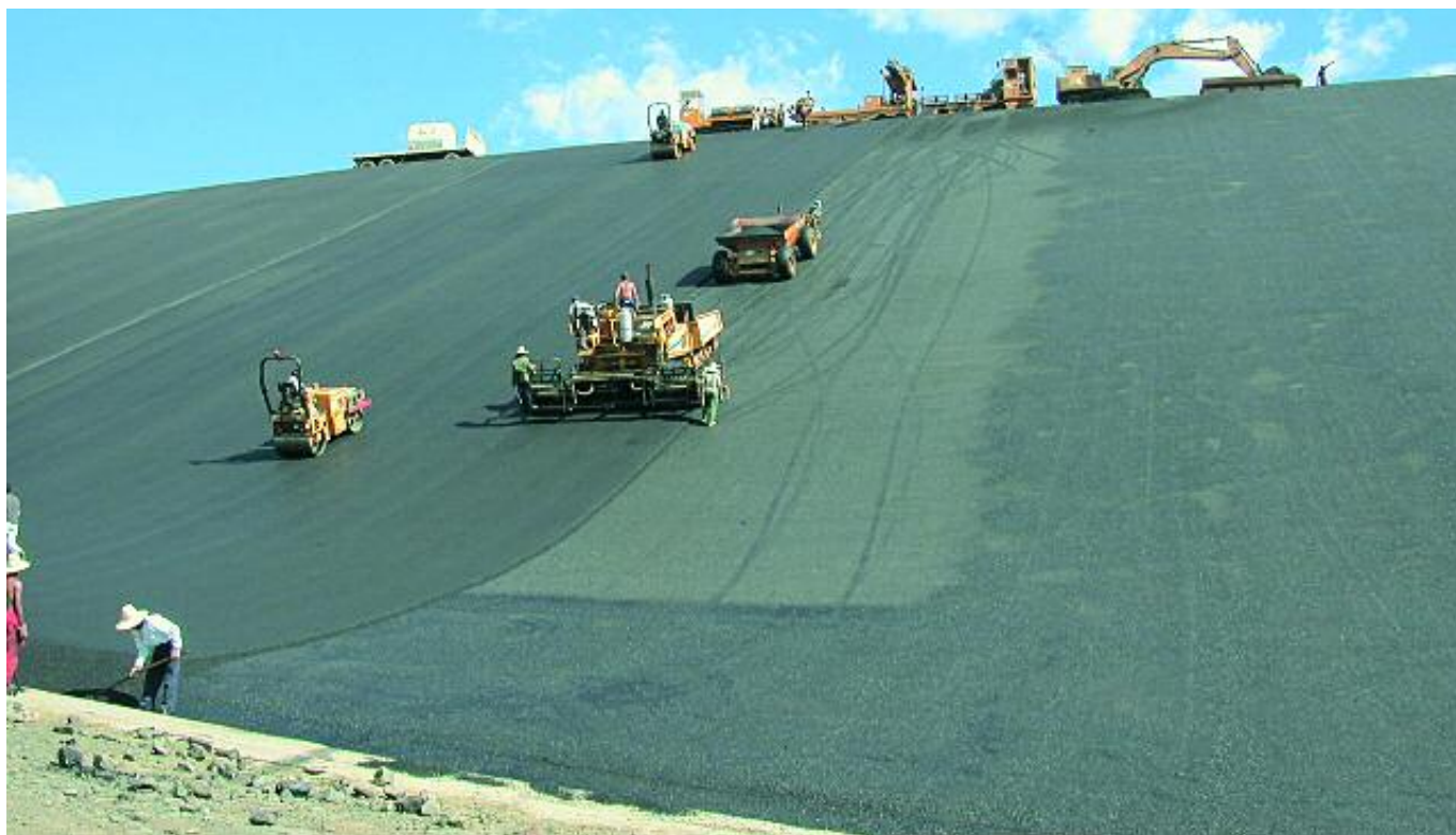
Fig. 4 Visione d'insieme dei macchinari in operazione durante una stesa
