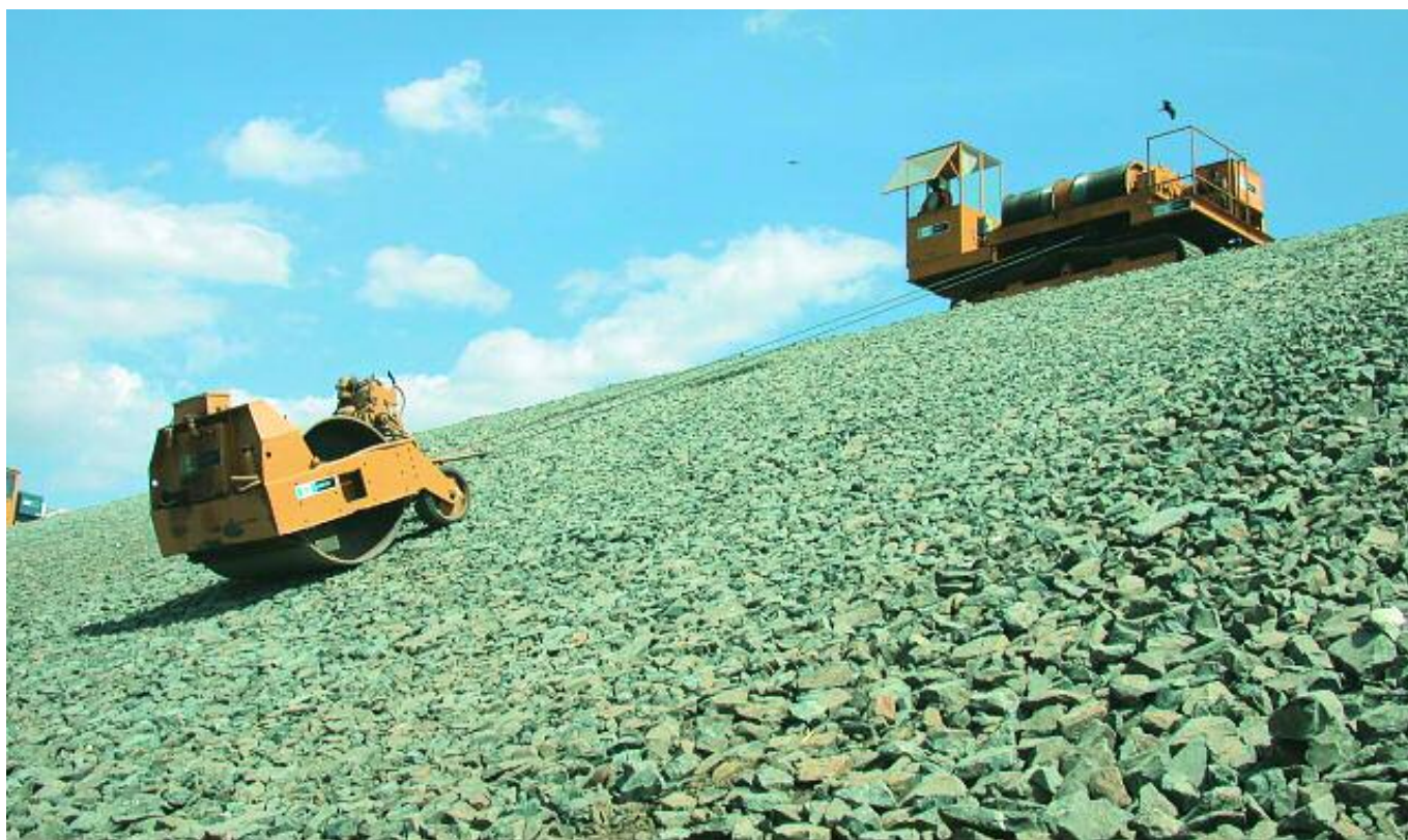
Fig. 7 Rullatura preliminare su sottofondo grosso
