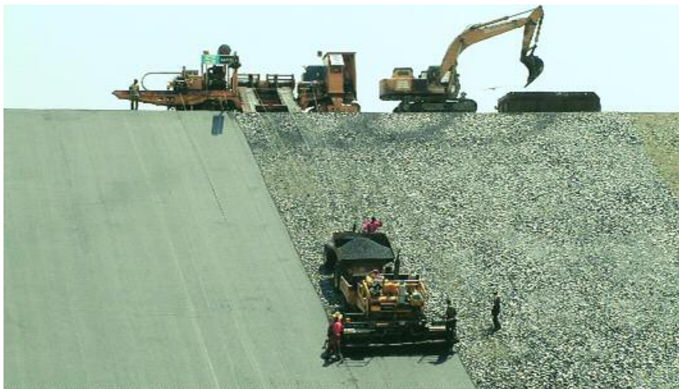
Fig. 5 Il carro argani principale assicura la finitrice, il dumper ed un rullo
