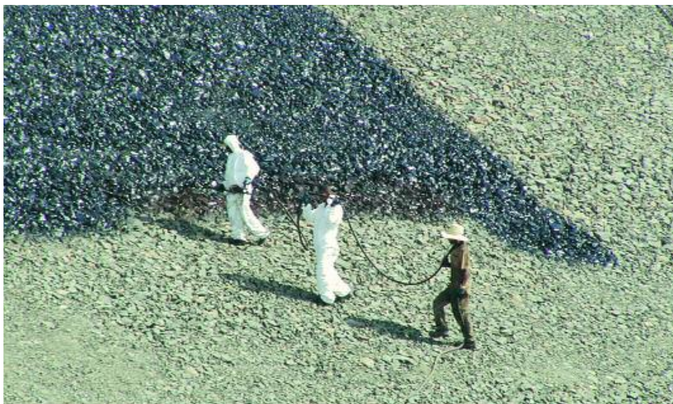
Fig. 8 Emulsione spruzzata sul sottofondo roccioso aperto
