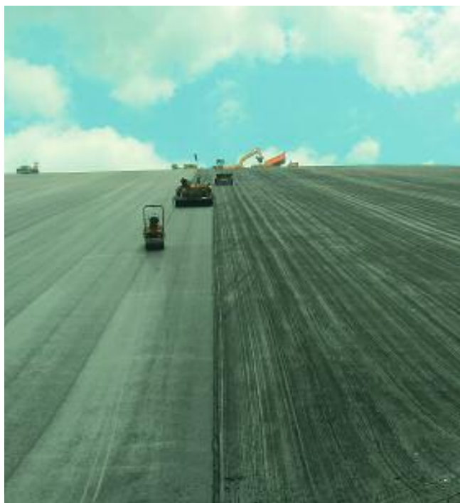
Fig. 10 Il rullo usa il brandeggio del cavo per operare dietro la finitrice subito dopo la stesa
