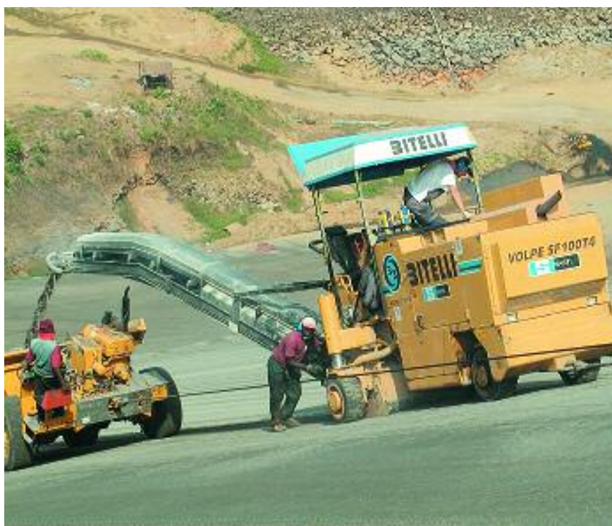
Fig. 15 La fresatura di un manto ammalorato
