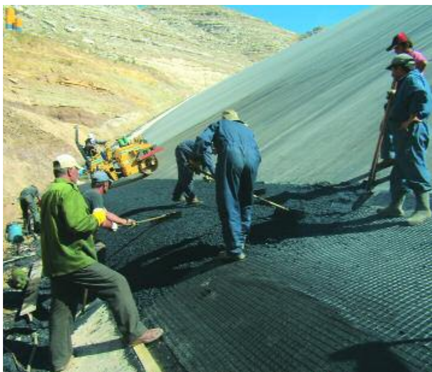
Fig. 13 Applicazione e intasamento della geotessile e successiva compattazione
