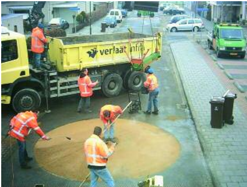
Fig. 3 Dosso stradale a Breda, Olanda
