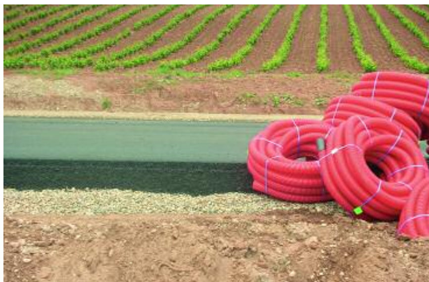
Fig. 9 Un cantiere aperto in Spagna
