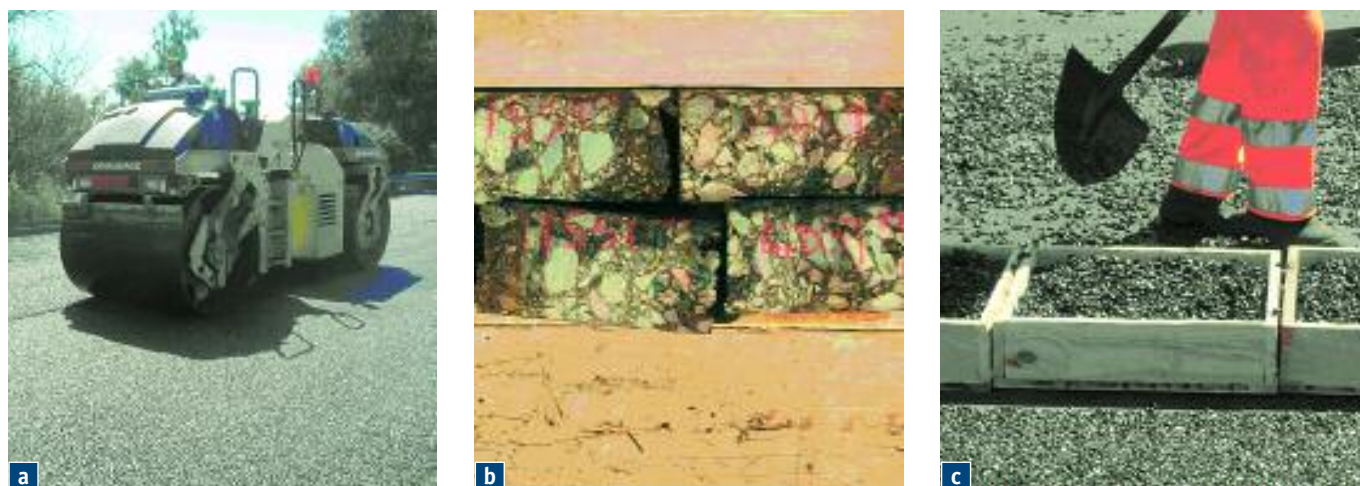
Fig. 1 Fasi di compattazione e prelievo campioni della miscela
