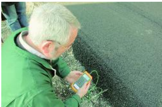
Fig. 3 Temperatura di stesa e compattazione
