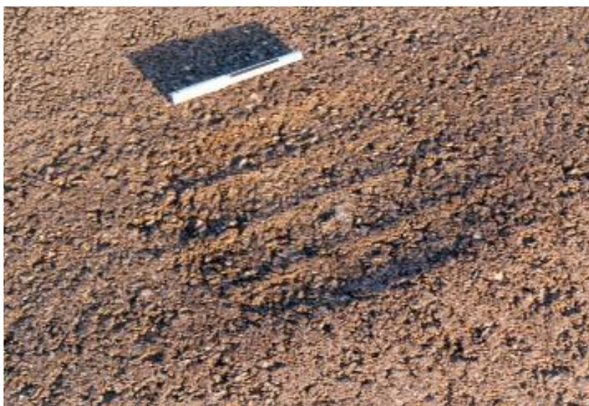
Fig. 1 Impronta lasciata dal velivolo EFA-Typhoon su una pavimentazione flessibile tradizione
