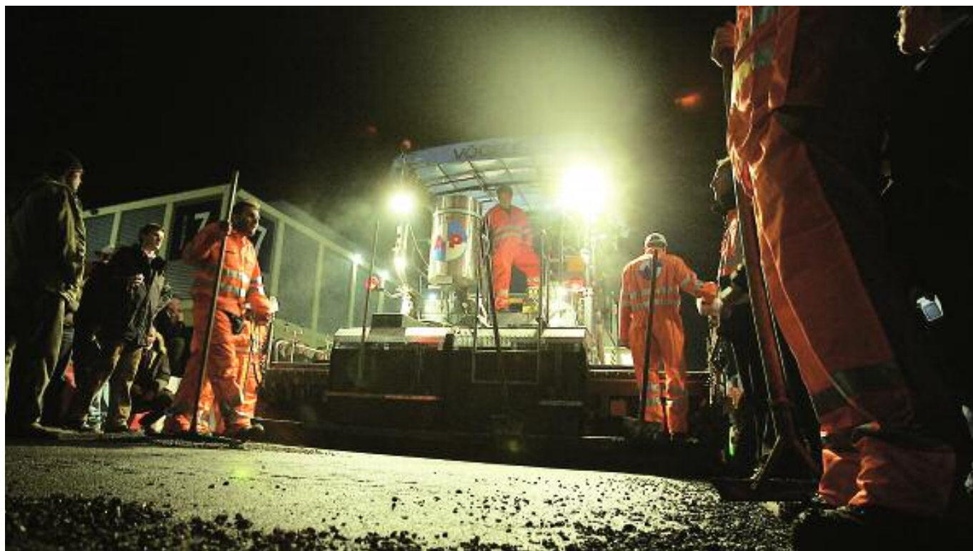
Fig. 11 Due momenti della prova pratica di stesa a bassa temperatura, curata da Arezzo Bitumi
