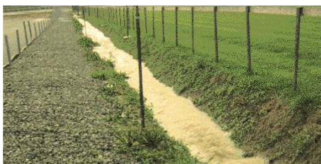
Fig. 5 Particolare dello strato drenante e opere di drenaggio
