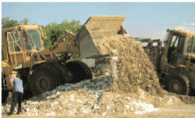
Fig. 9 Fase di miscelazione della sabbia con le fibre
