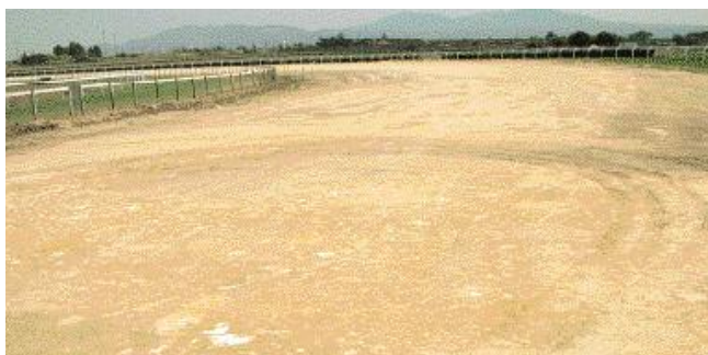
Fig. 3 Il sottofondo in pietra di travertino
