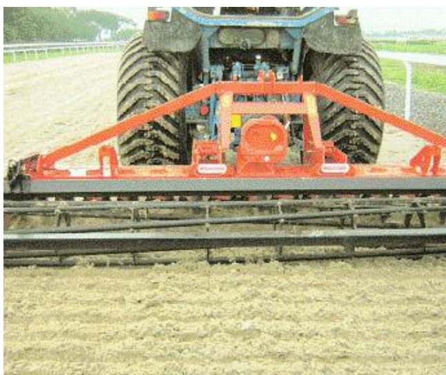
Fig. 10 Finitura del manto sintetico
