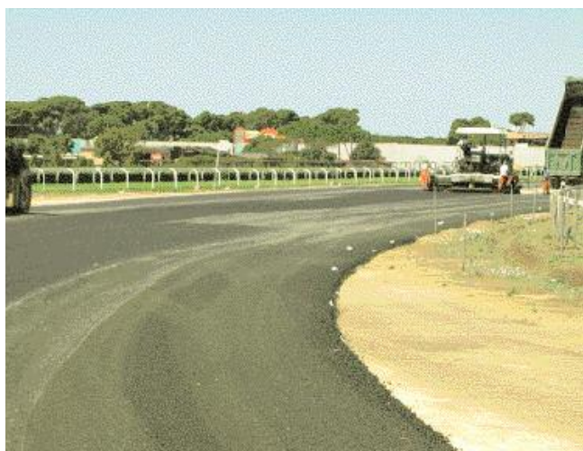
Fig. 7 La stesa dello strato drenante
