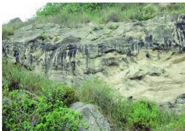
Fig. 5 Trasudi di bitume dalla roccia
