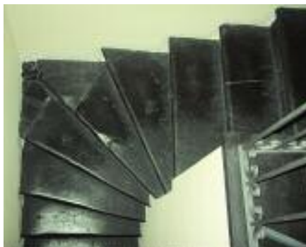
Fig. 7 La scala che porta nelle cantine di una casa privata
