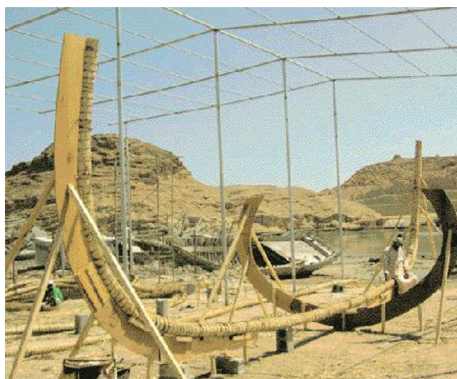
Fig. 8 La struttura di legno su cui è stata costruita la barca
