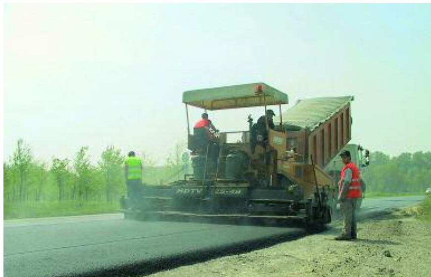
Fig. 5 Stesa dello strato di 10 cm (tappeto + binder)
