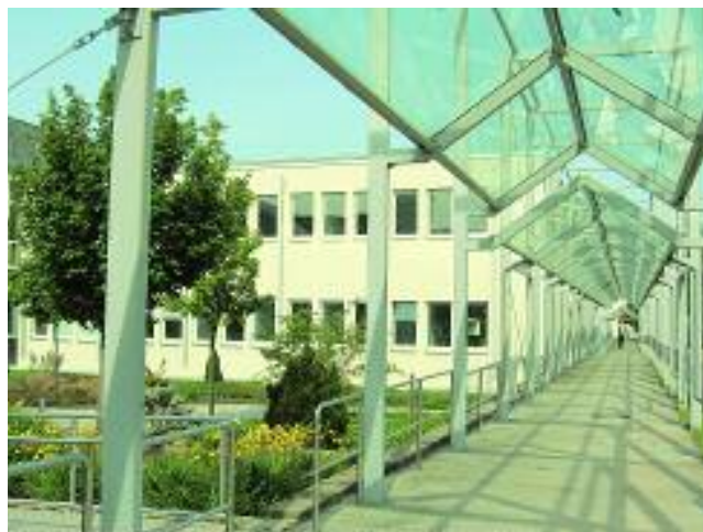
Fig. 2 Veduta parziale delle strutture della BG Akademie
