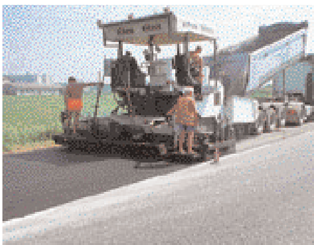
Fig. 4 Fasi di esecuzione dell'intervento di riciclaggio
