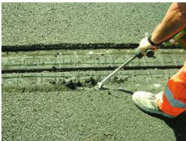
FIG. 6a Demolizione conglomerato posato sul giunto
