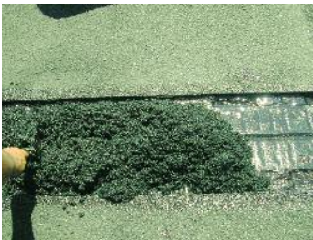
FIG. 6c Posa della cappa insonorizzante
