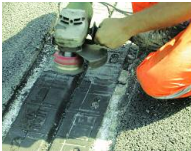
FIG. 6b Irruvidimento della superficie del giunto
