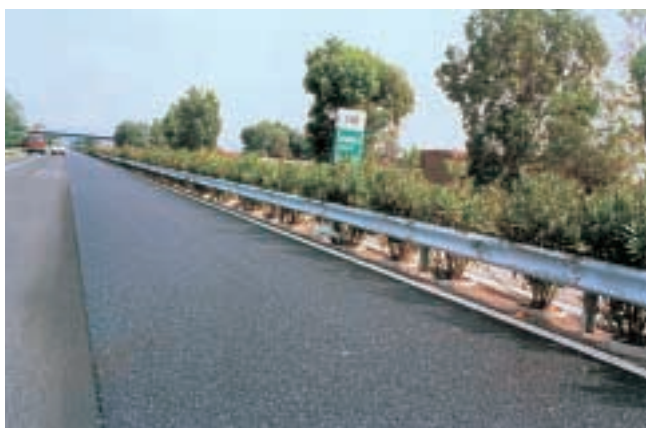
FIG. 8 Vista della pavimentazione rigenerata e della pavimentazione da rigenerare
