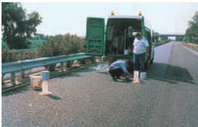
FIG. 6 Prove di permeabilità in sito eseguite sul drenante rigenerato
