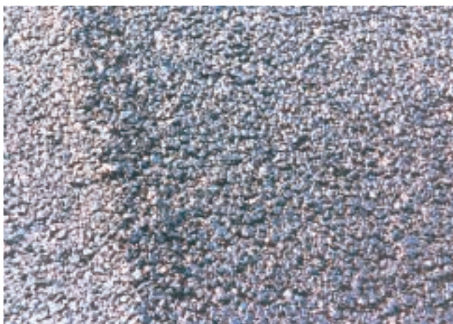
FIG. 7 Particolare del giunto di unione delle strisciate della pavimentazione rigenerata
