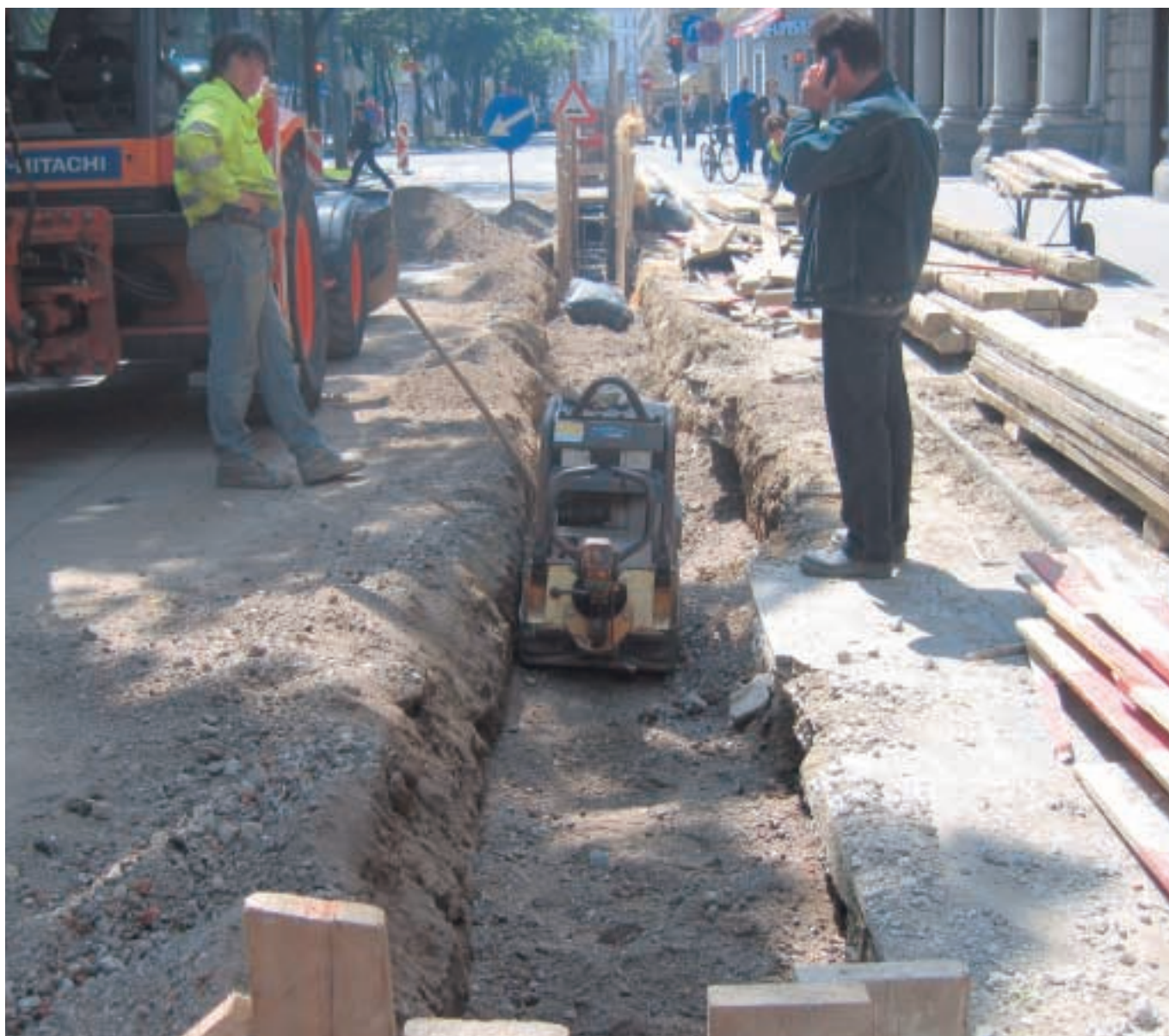
FIG. 4 Lavori stradali in città
