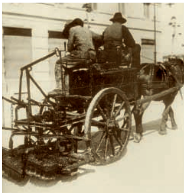
FIG. 2 Stesa di catrame con scope
