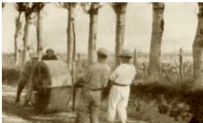
FIG. 1 “Compattazione” con rullo trainato a mano
