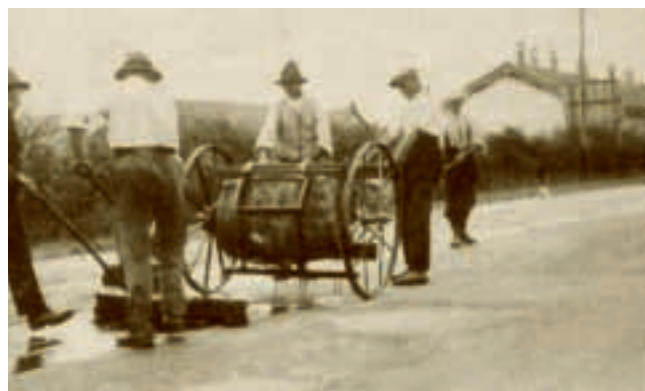
FIG. 4 Procedimento di stesa del catrame
