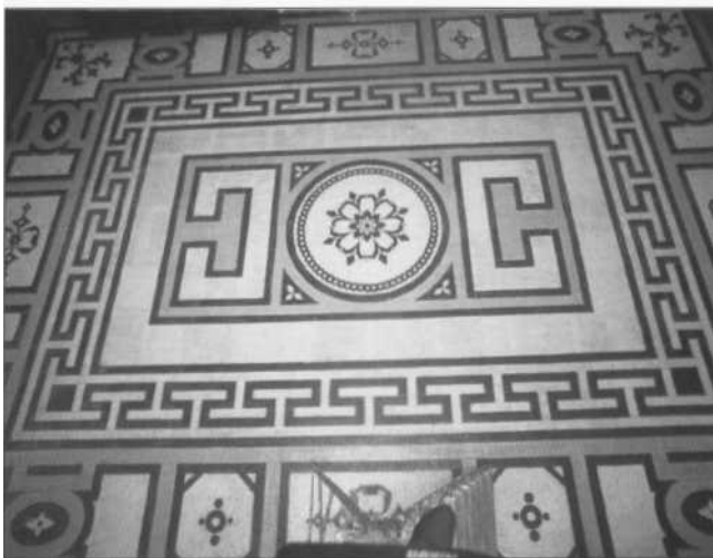
Fig. 3 - Pavimento siciliano fatto con asfalto naturale e pietra calcarea
