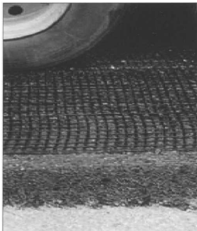
Fig. 6 - Applicazione di una geogriglia
