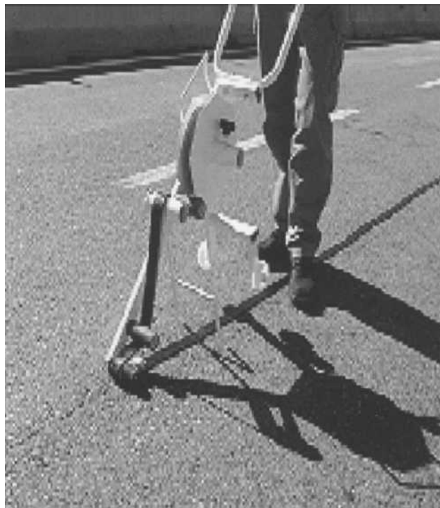
Fig. 3 - Posa in opera con applicatore manuale
