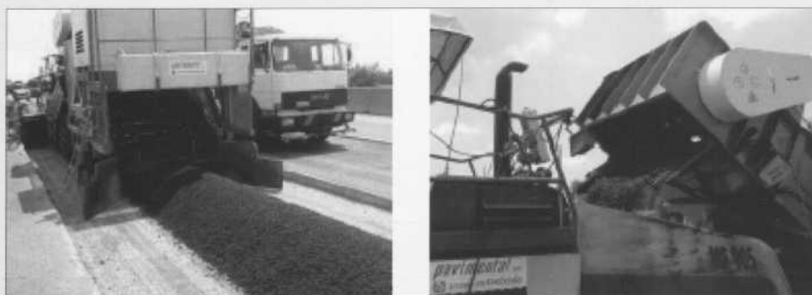
Fig. 8 - Il caricamento della miscela rigenerata nella vibrofinitrice
