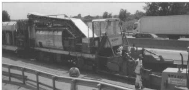
Fig. 5 - Il trasporto del fresato al gruppo mescolatore
