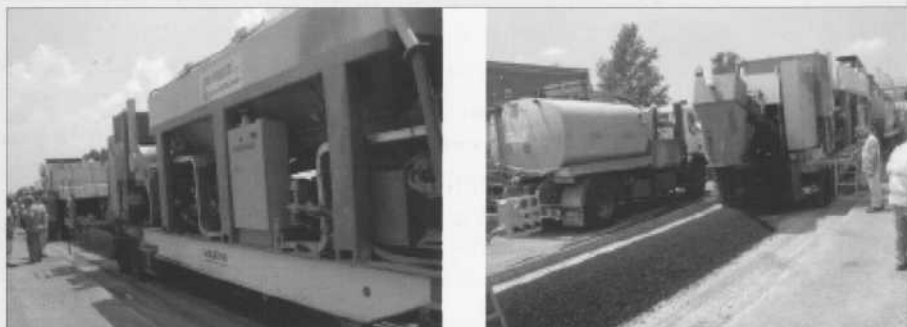
Fig. 7 - Il gruppo mescolatore a) e lo scarico della miscela rigenerata b)
