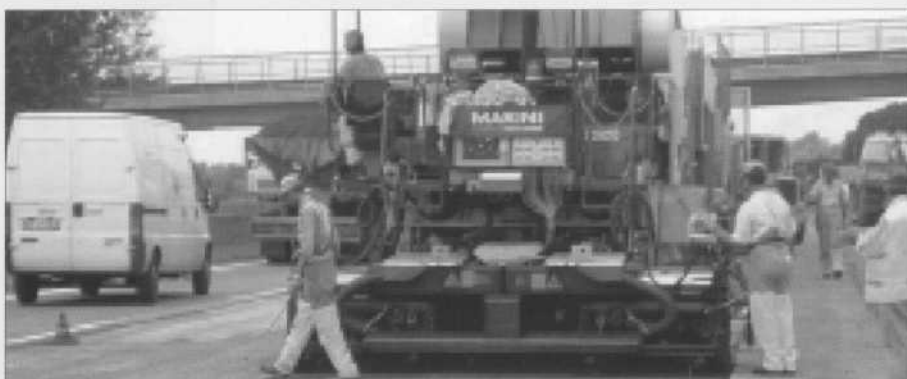
Fig. 9 - Stesa della miscela con la vibrofinitrice
