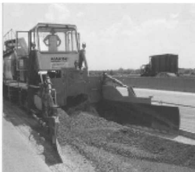
Fig. 4 - Il caricamento del fresato
