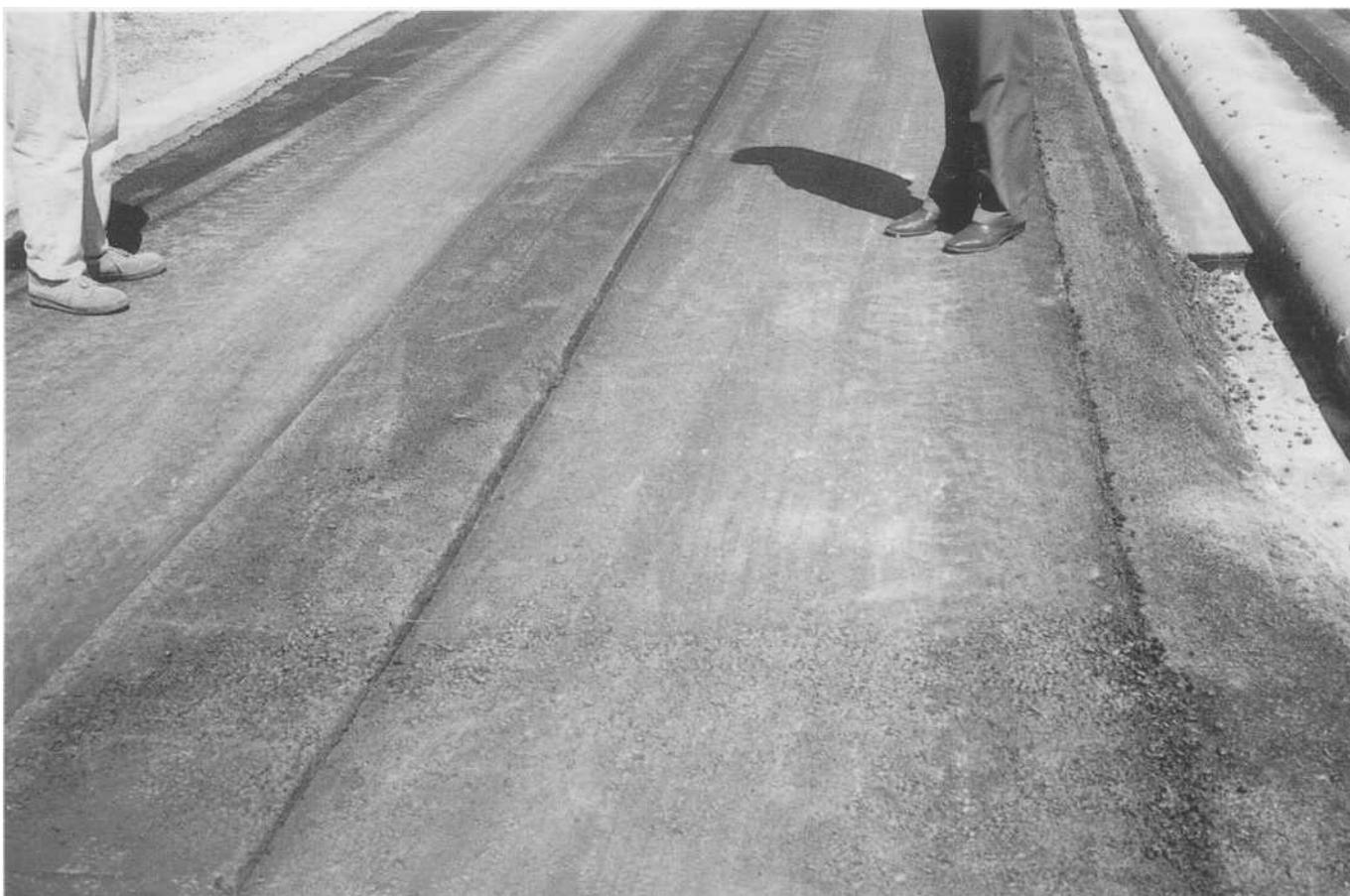
**Fig. 3 - Particolare del 2° strato di conglomerato con lo zoccolo centrale in evidenza**
