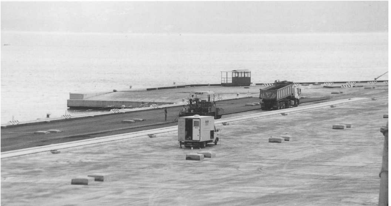
Fig. 3 - Il laboratorio mobile sul cantiere del porto
