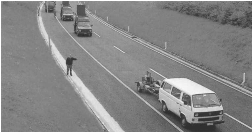
Foto 1 - Prove di portanza con il Falling Weight Deflectometer
