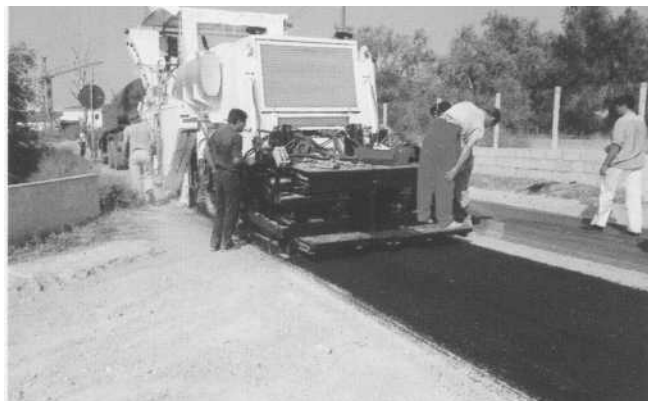
Riciclaggio a freddo su strada comunale. In primo piano: pavimentazione riciclata e finitrice applicata alla fresatrice
