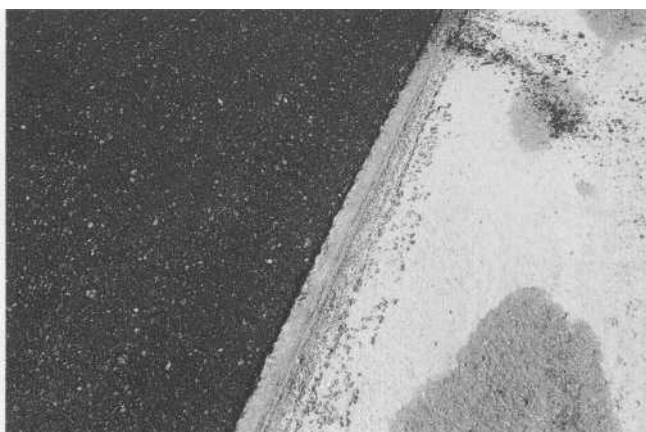
Particolare della superficie del manto stradale prima e dopo il riciclaggio a freddo
