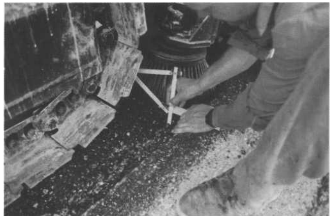
Particolare della superficie del manto stradale prima e dopo il riciclaggio a freddo
