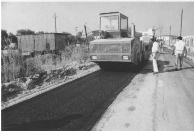
Immediata compattazione della pavimentazione riciclata
