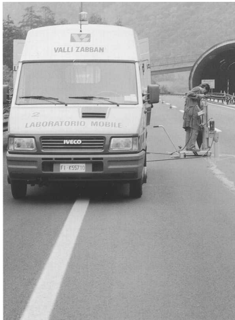
Laboratorio mobile: carotaggio lavori svolti
