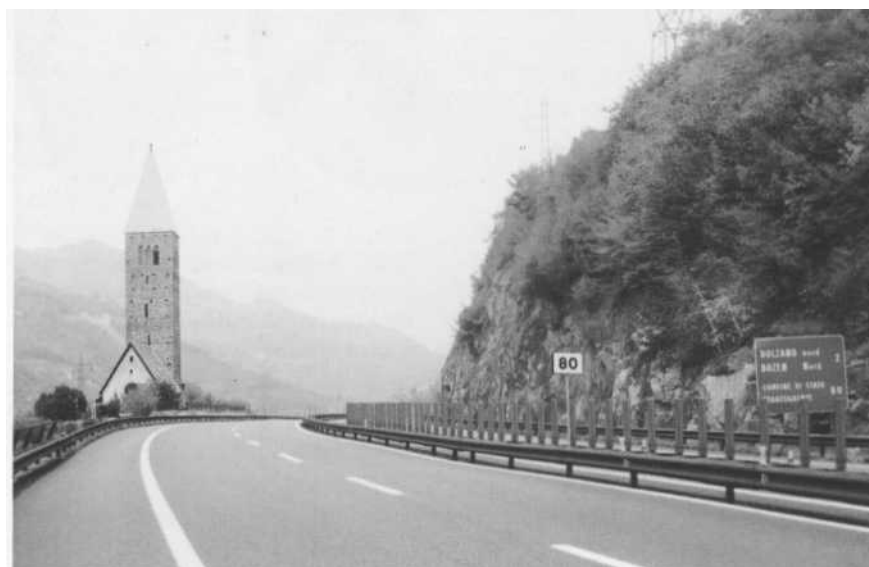
Tratto completato con usura drenante fonoassorbente
