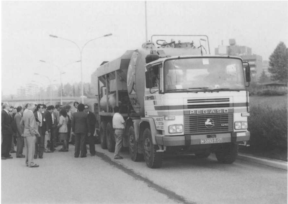
Figure 11. Sopralluogo dei partecipanti al Convegno sul Microtappeto Slurry-Seal ad una applicazione in corso sull'Asse Sud-Ovest di Bologna.
