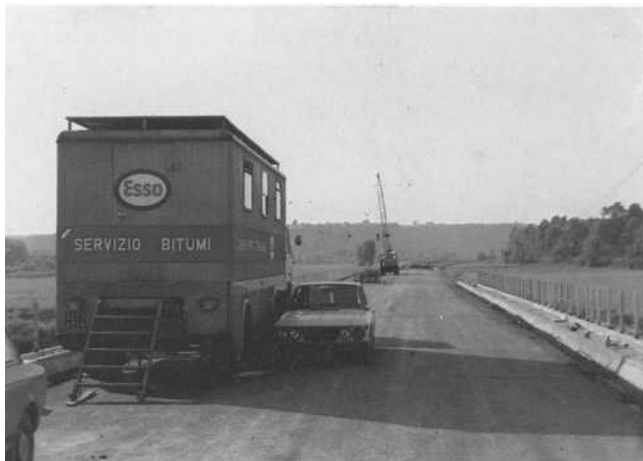
Fig. 13. 1° lotto. Laboratorio mobile per il controllo dei materiali in opera.
