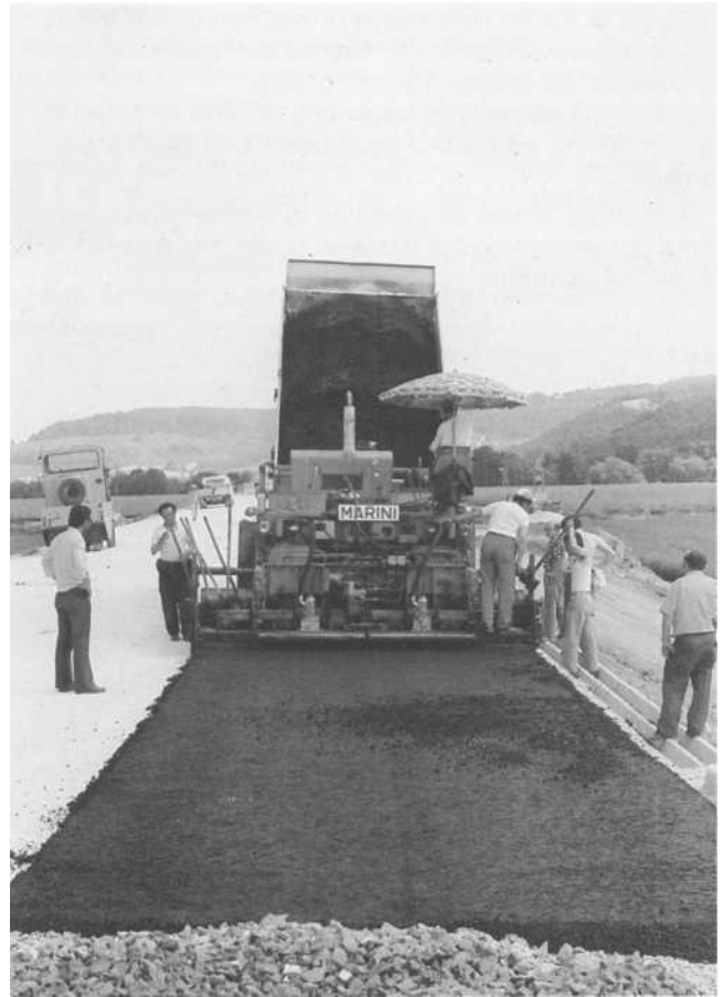
Fig. 11. Posa in opera del conglomerato bituminoso tra 1° e 2° lotto.
