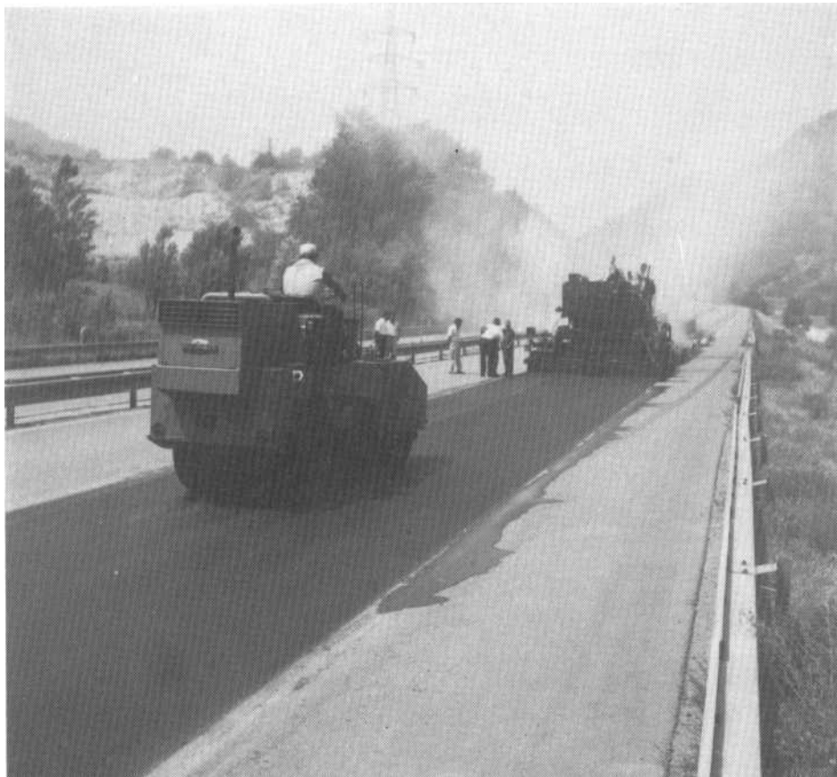
Fig. 1-2 - Scarifica (fresatura a caldo) e riciclaggio in sito del vecchio conglomerato bituminoso («termo-rigenerazione») sull'Autostrada Quincinetto-Aosta.
