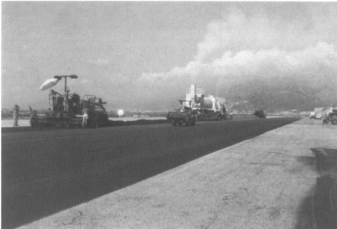
Figg. 3-4 - Scarifica (fresatura a freddo) e riciclaggio in sito del vecchio conglomerato con impianto mobile sulla pista di volo dell'Aeroporto civile di Genova.
