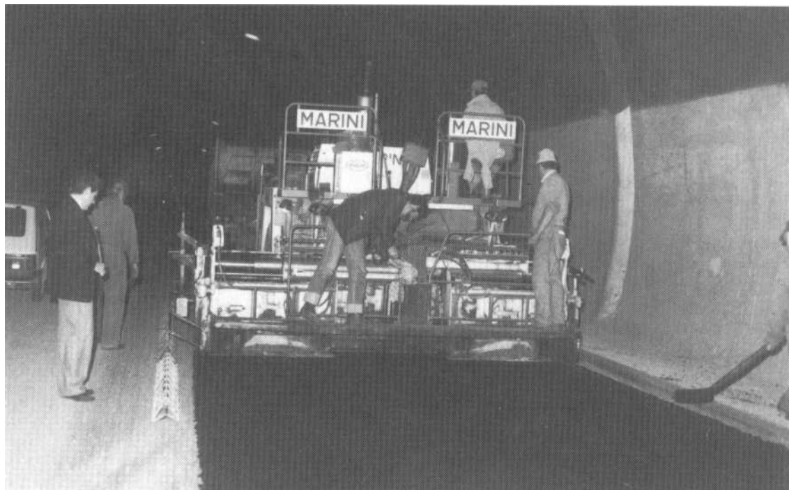
Figg. 7-8 - Riciclaggio in centrale del vecchio conglomerato bituminoso recuperato e riapplicazione del conglomerato riciclato sull'Autostrada Savona-Ventimiglia.
