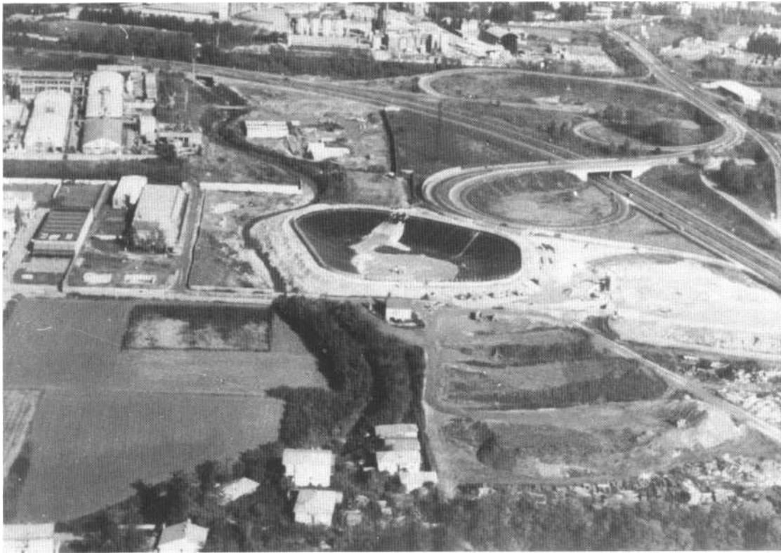
Fig. 4 - La vasca di accumulo N. 1 (capacità 80.000 m 3 ) e, in fregio, il torrente Certesa.
