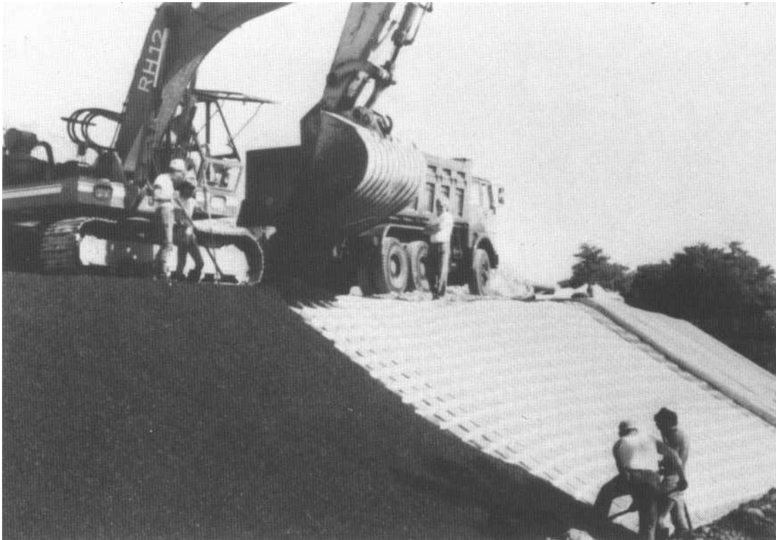
Figg. 7-8 - Stesa e distribuzione del conglomerato bituminoso con escavatore a braccio con benna non dentata.
