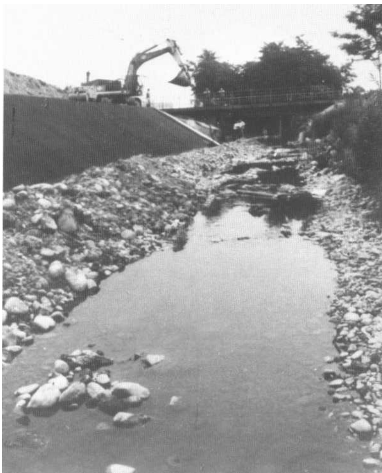
Figg. 9-10 - La rullatura del conglomerato bituminoso ed il rivestimento protettivo completato.
