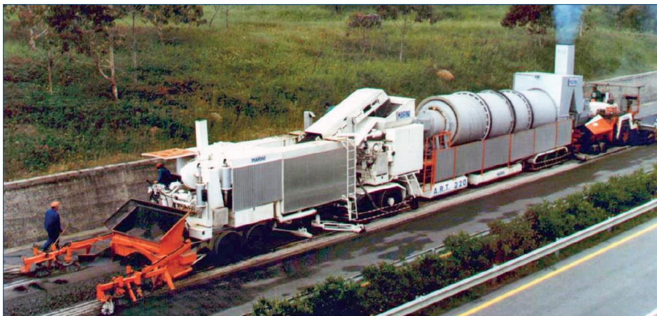
**Fig. 10** Impianto A.R.T. 220 Marini (riciclaggio a caldo in situ)
