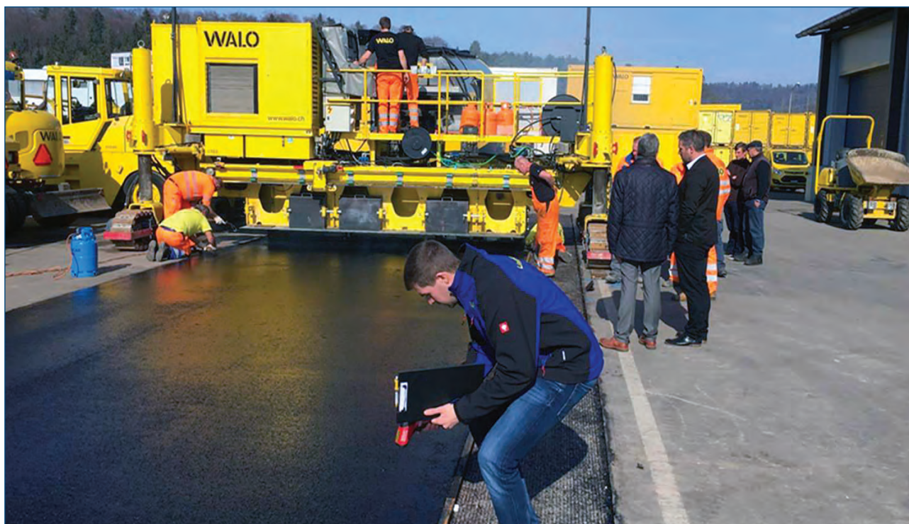
Fig. 6 Una stesa di colato su strada
