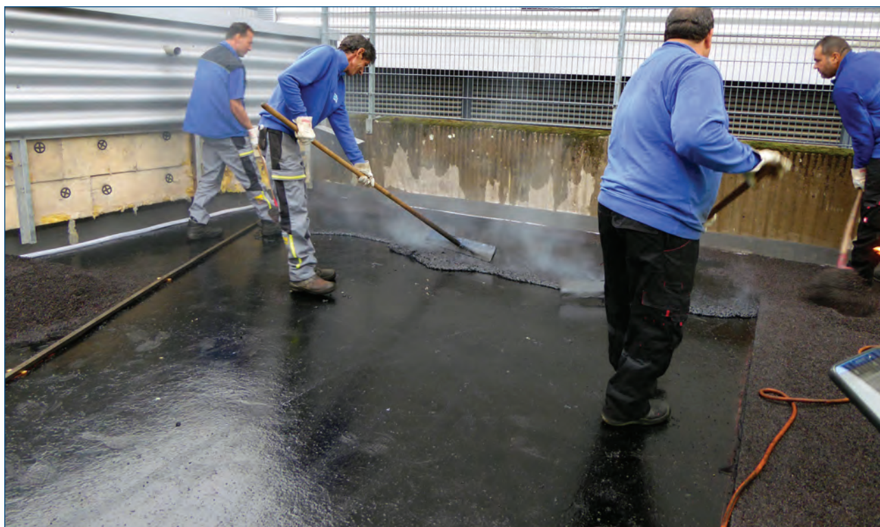
Fig. 3 La stesa della seconda mano di colato, dopo il trattamento deumidificante della superficie con la fiamma ossidrica.
