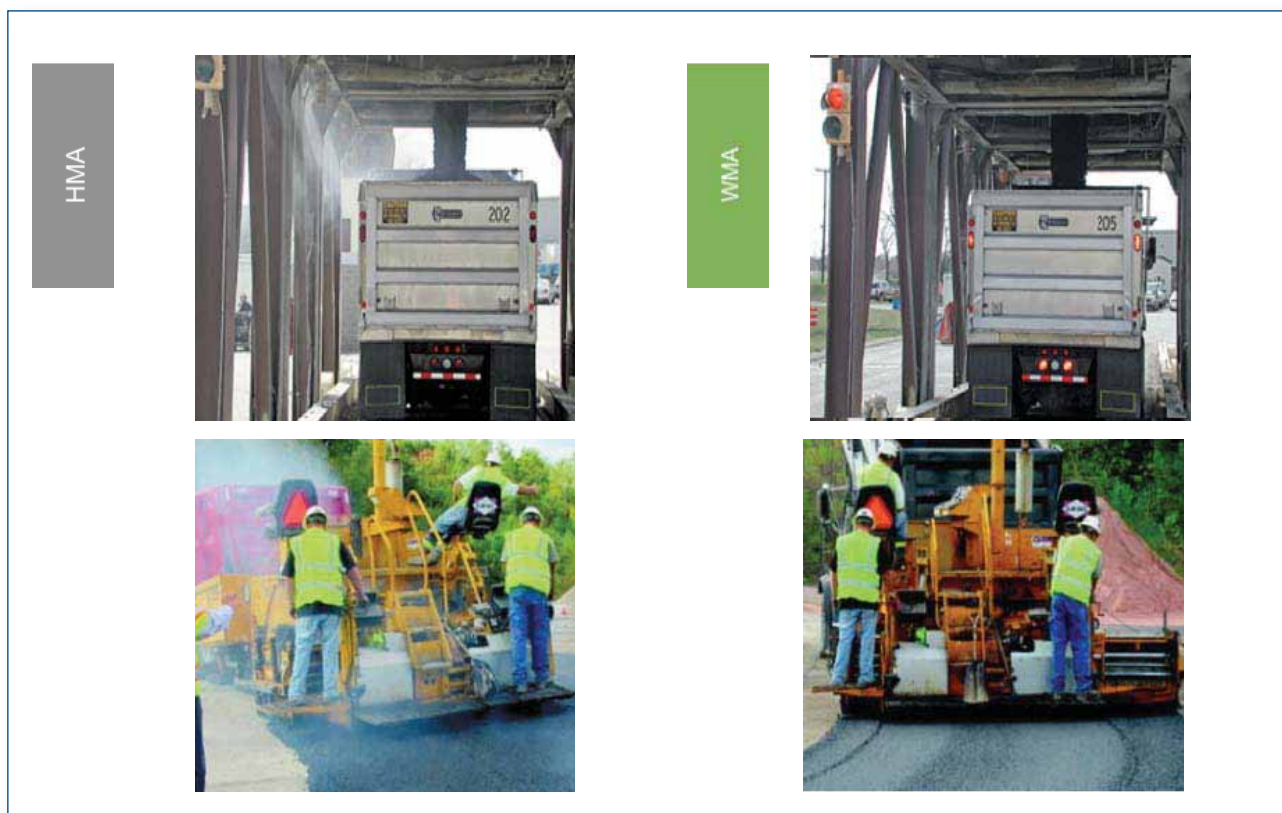
Fig. 2 Confronto visivo tra produzione e stesa di conglomerato caldo e tiepido.
